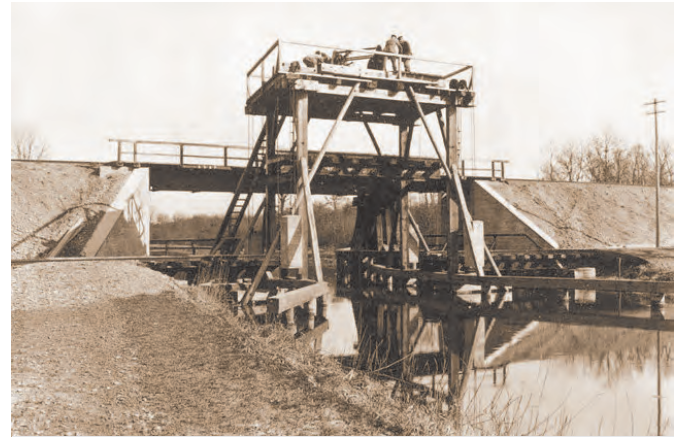
Point de passage du canal du Rhône au Rhin à Niffer - 1918
