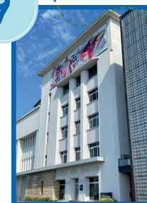
USINE HYDROELECTRIQUE CENTRALE EDF
